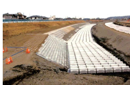
多摩川平山橋下流低水護岸工事 (東京都日野市豊田)
